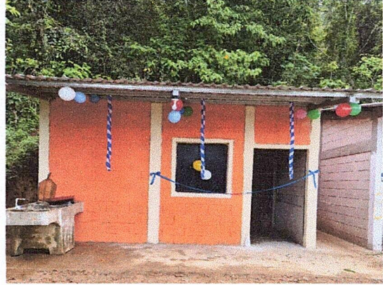
Foto 2: Reparación y mejoramiento general de cocina.
