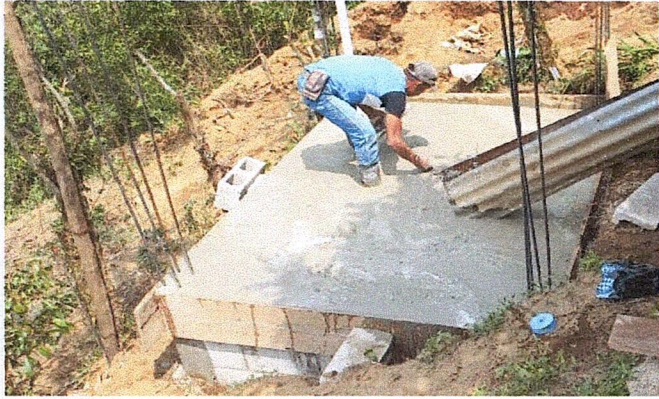
Foto 1: Mejoramiento general de sanitario y fosa séptica
